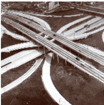
Intersecção da I-101 e I-110, Los Angeles, Califórnia (ainda em construção, 1953)
