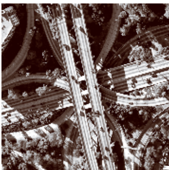
Intersecção da I-101 e I-110, Los Angeles, Califórnia (já pronta)
